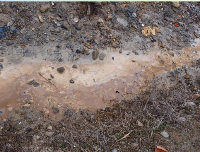
LIXIVIADOS Y PRECIPITADOS DE SOSA EN LA CUNETETA
