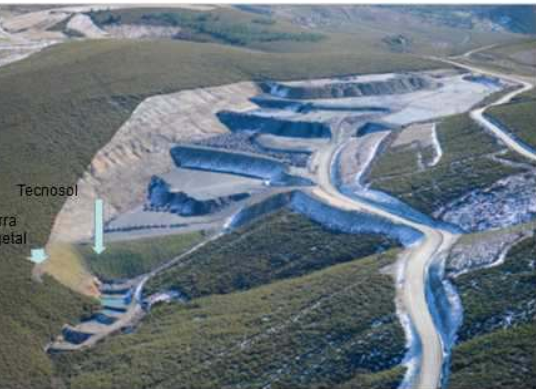
Primeros ensayos de recuperación de escombreras de materiales ampelíticos extraídos en la construcción del túnel del Espiño. (Línea de alta velocidad Madrid-La Coruña).
